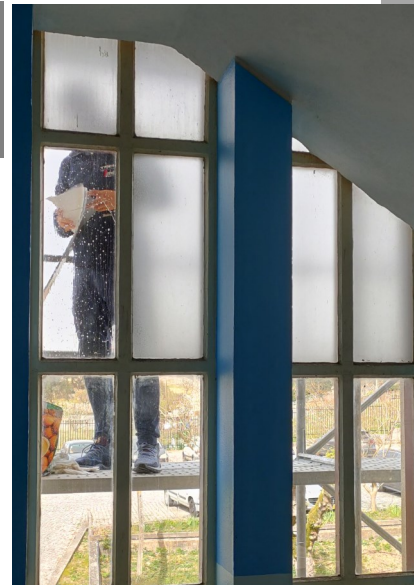
COLOCAÇÃO DE VINIL FOSCO NAS ESCADAS
